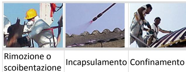
**La rimozione:** presenta il vantaggio di eliminare definitivamente il problema amianto e conseguentemente ogni programma di manutenzione e controllo. Presenta comunque l'inconveniente di essere una operazione dispendiosa, che comporta un elevato rischio di contaminazione ambientale se non viene condotta con scrupolosa osservanza delle norme tecniche, e produce rifiuti pericolosi.
