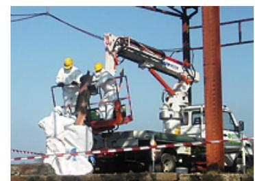
Un intervento di rimozione eseguito da imprese poco esperte può elevare pericolosamente la concentrazione di fibre di amianto nell'aria respirabile nonché una contaminazione ambientale e determinare un aumento del rischio di malattie da amianto.
